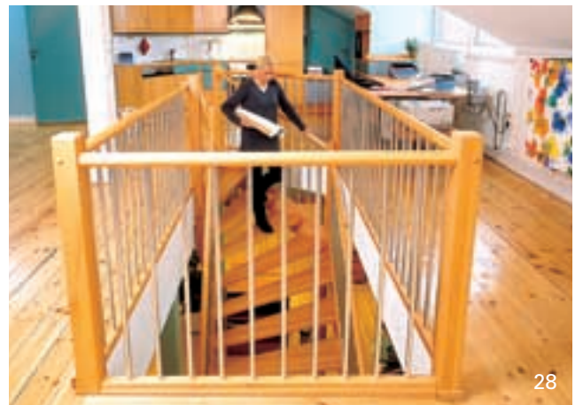
Rækværk rundt om et trappehul. Rund håndliste i lakeret bøg. Balustre af blankpoleret metal. Stolpe D1.
