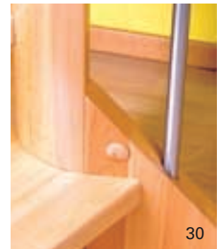
Bøjning med radiusfræset hjørnetrin.
