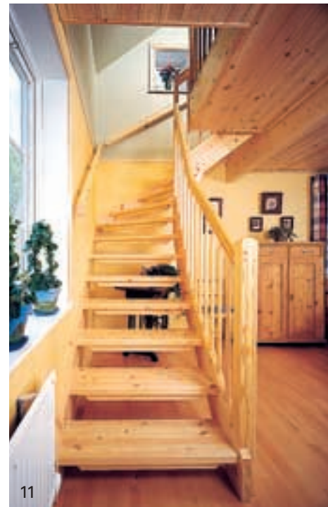
Åben L-trappe i massiv fyr. Balustre nr. 4 och stolpe D1.
