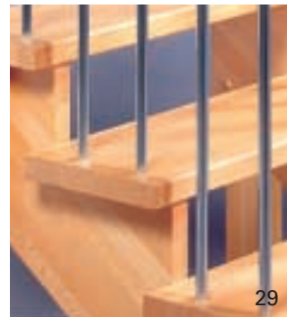
Ved opsadlede trin er balustrene boret ned i trinene.
